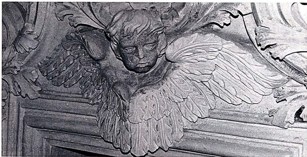
Opera in corso di restauro.
